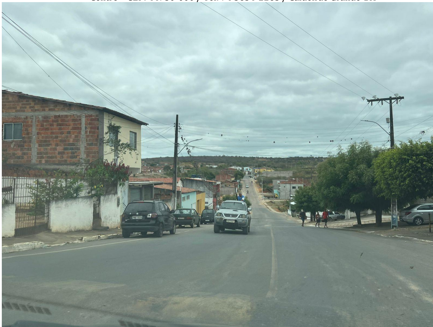
Postes da avenida Hélio Correia
