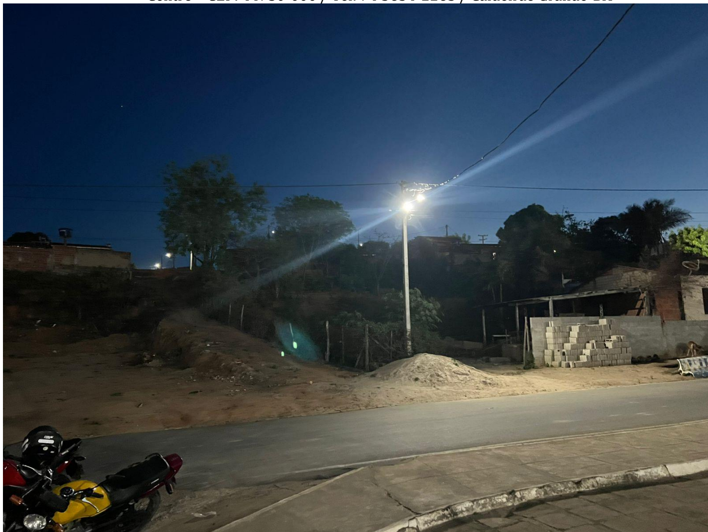
Postes da rua da lagoa
