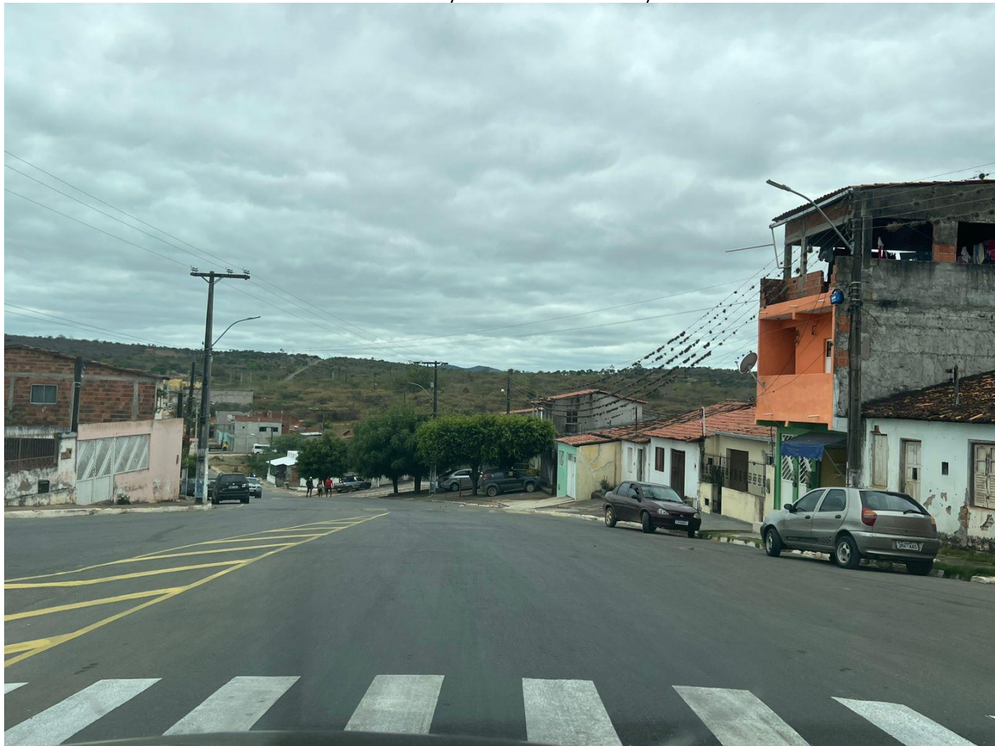
Postes da avenida Hélio Correia
