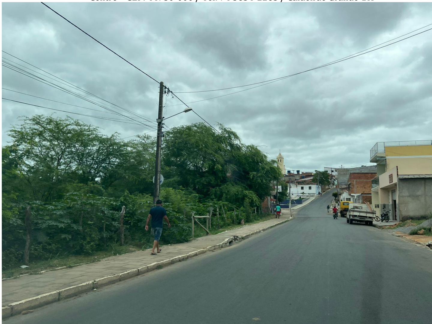
Postes próximos a Ladeira do antigo quartel
