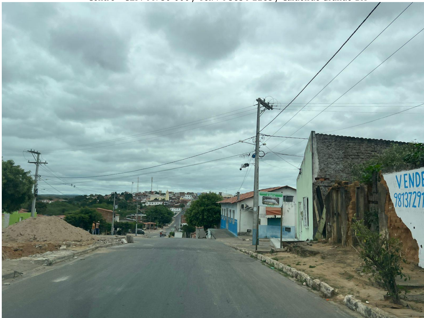
Postes da Zona escolar (escola Monteiro Lobato)
