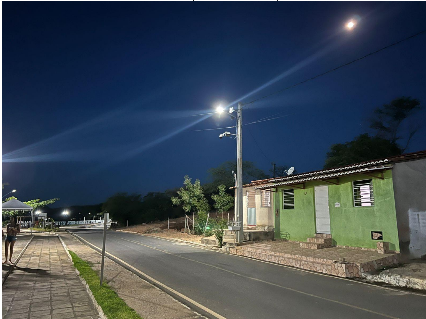
Postes da rua da lagoa
