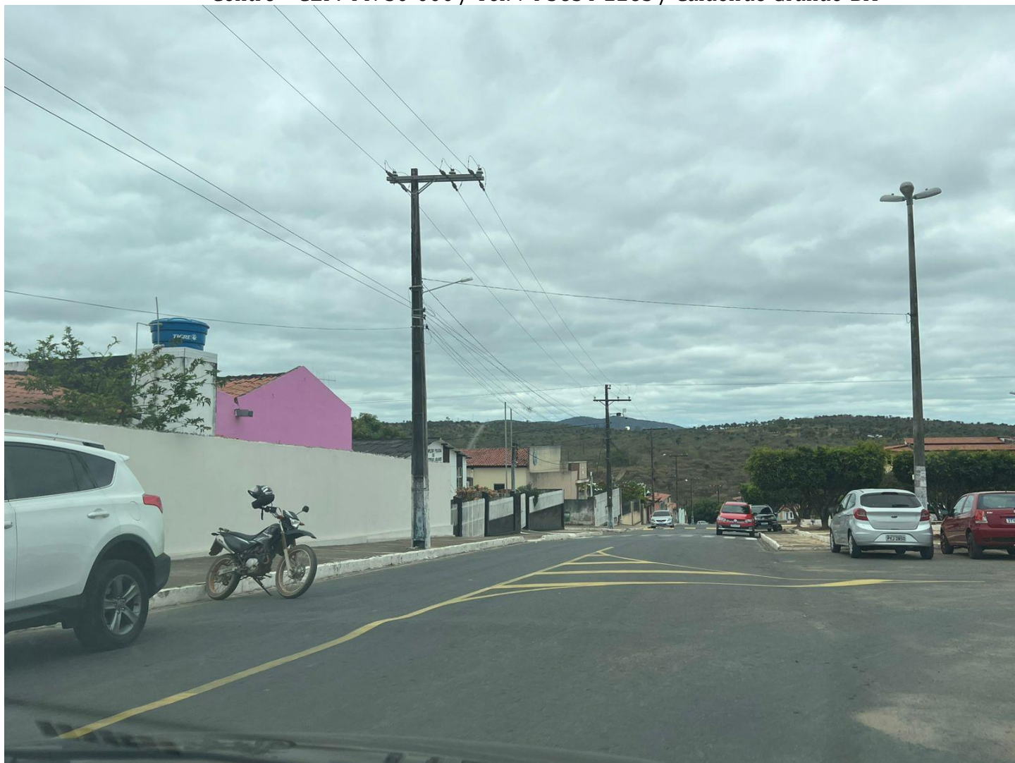
Postes da zona escolar (colégio Cenecista)
