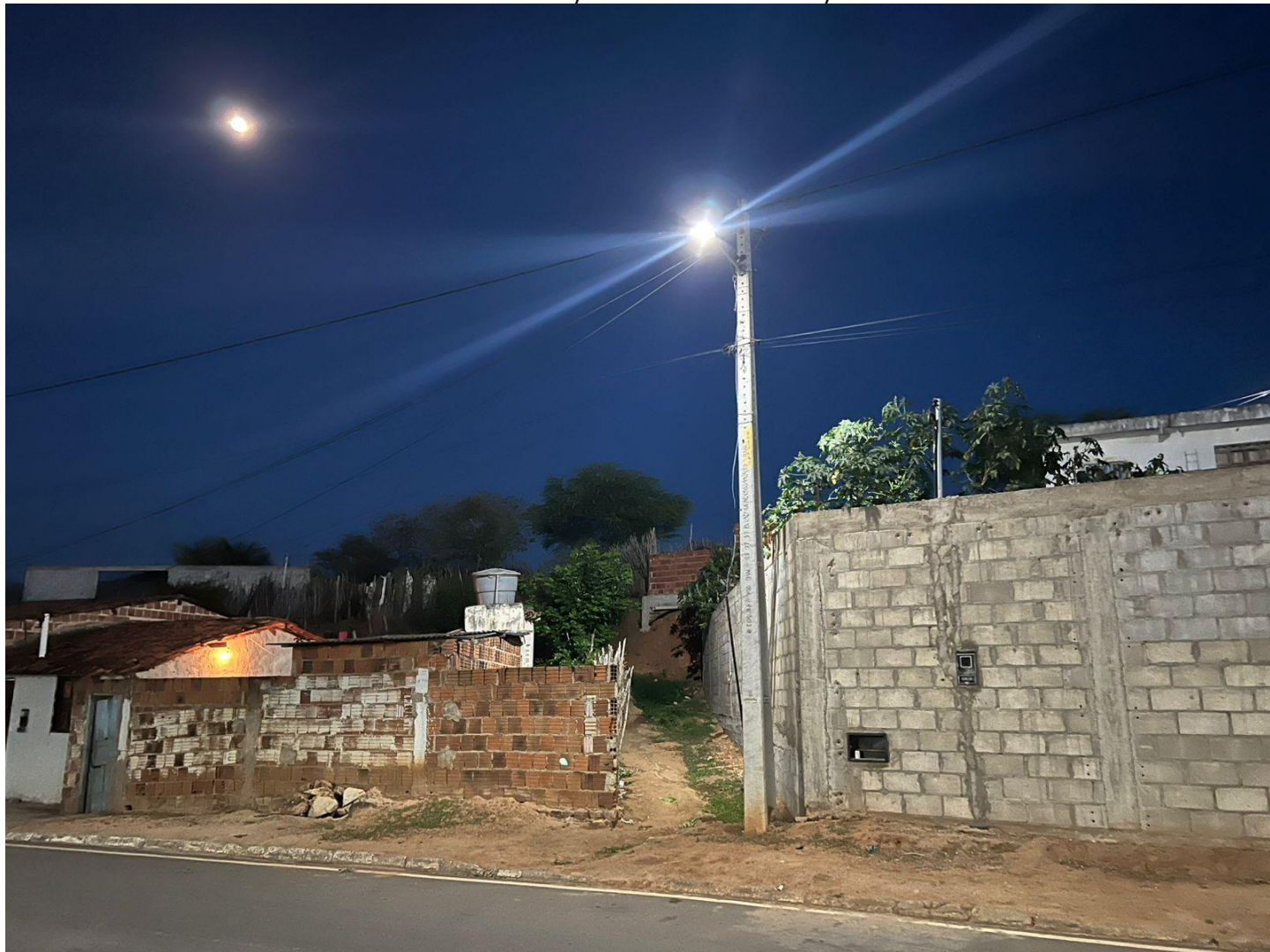
Postes da rua da lagoa
