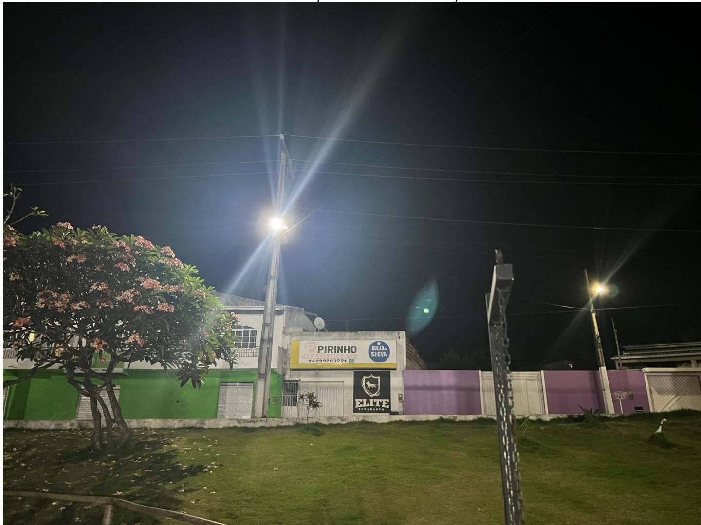
Postes da rua da lagoa
