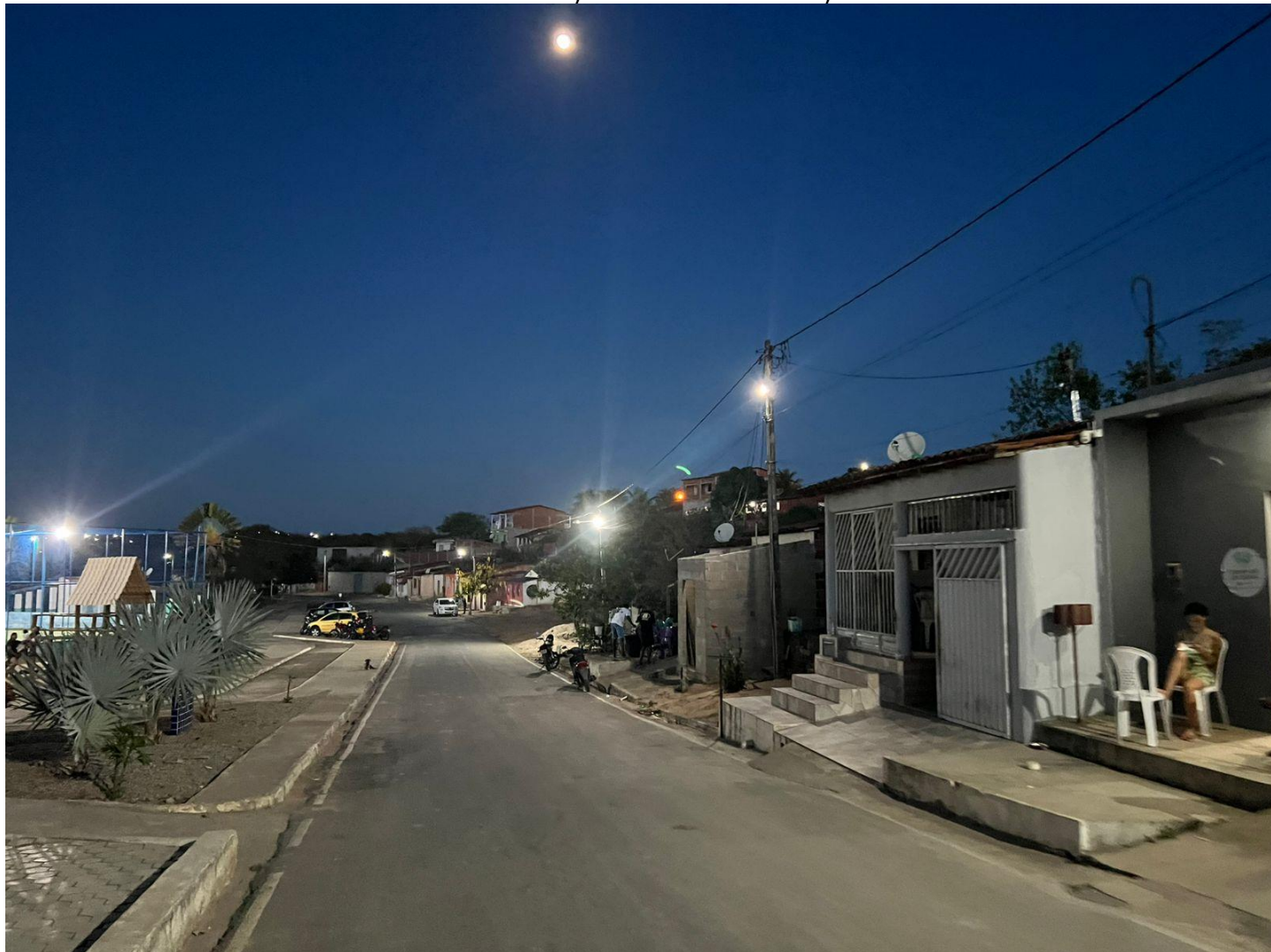
Postes da rua da lagoa
