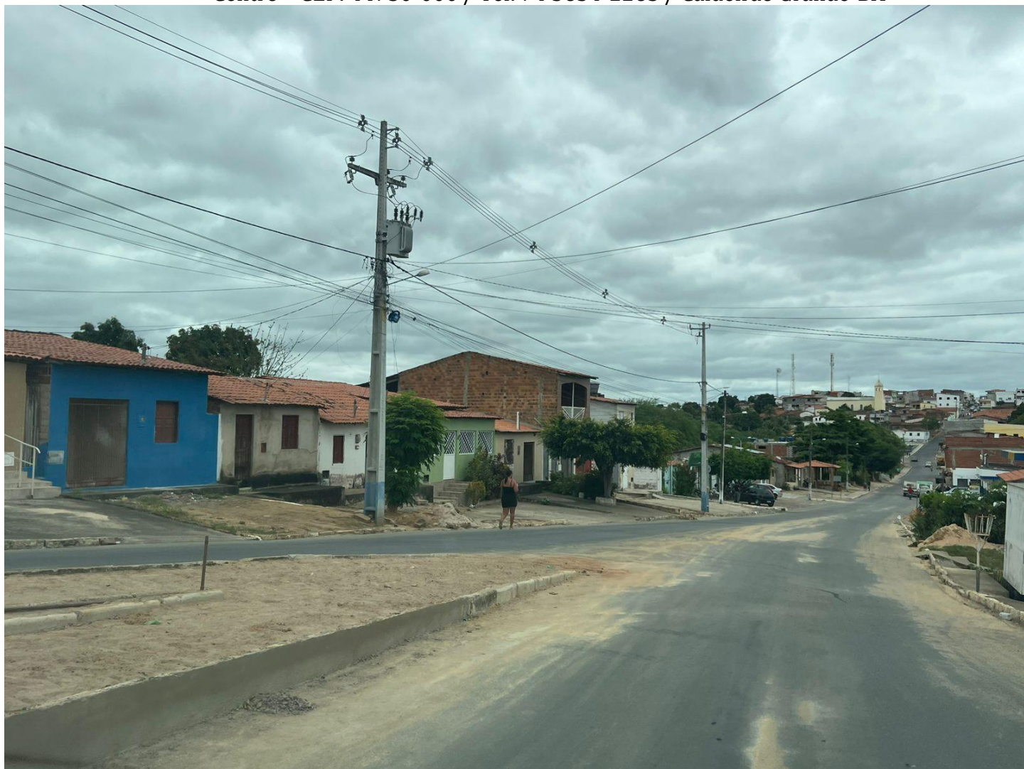
Postes da zona escolar (cempas)
