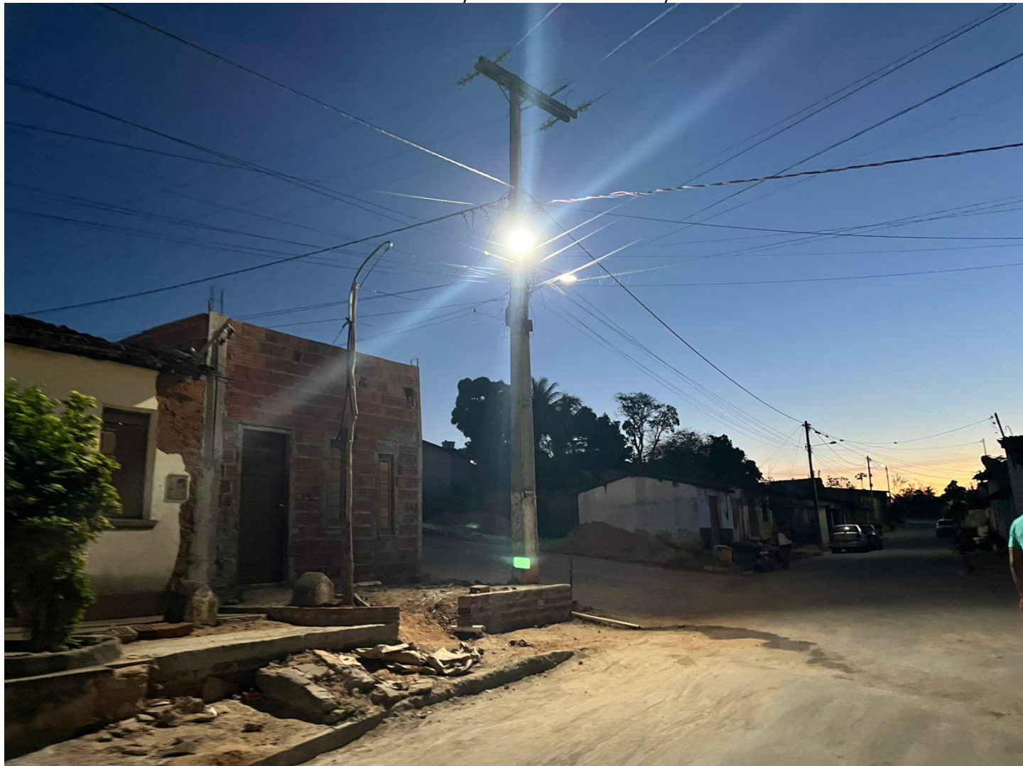
Postes da rua da lagoa
