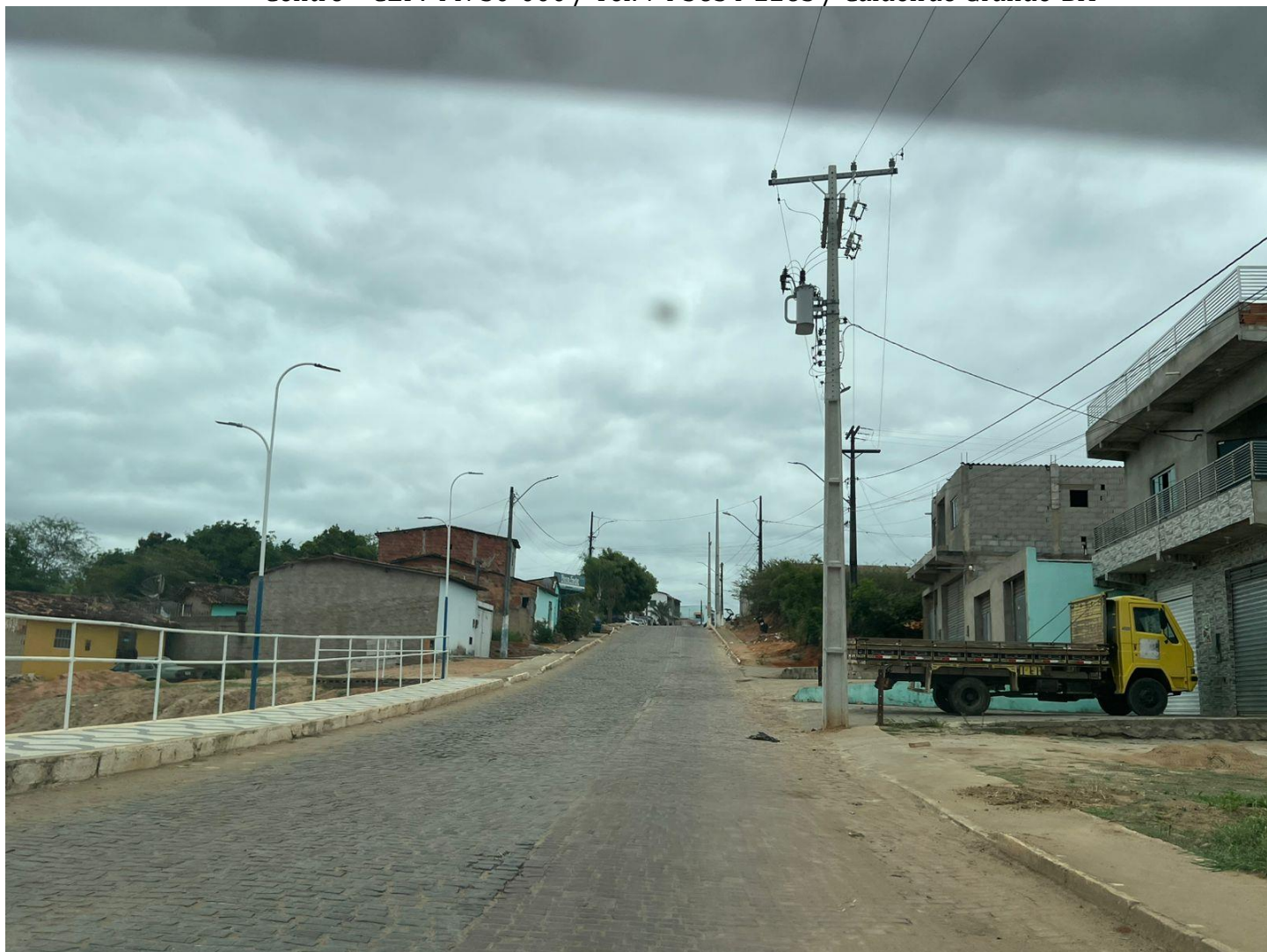
Postes da Rua do Açude
