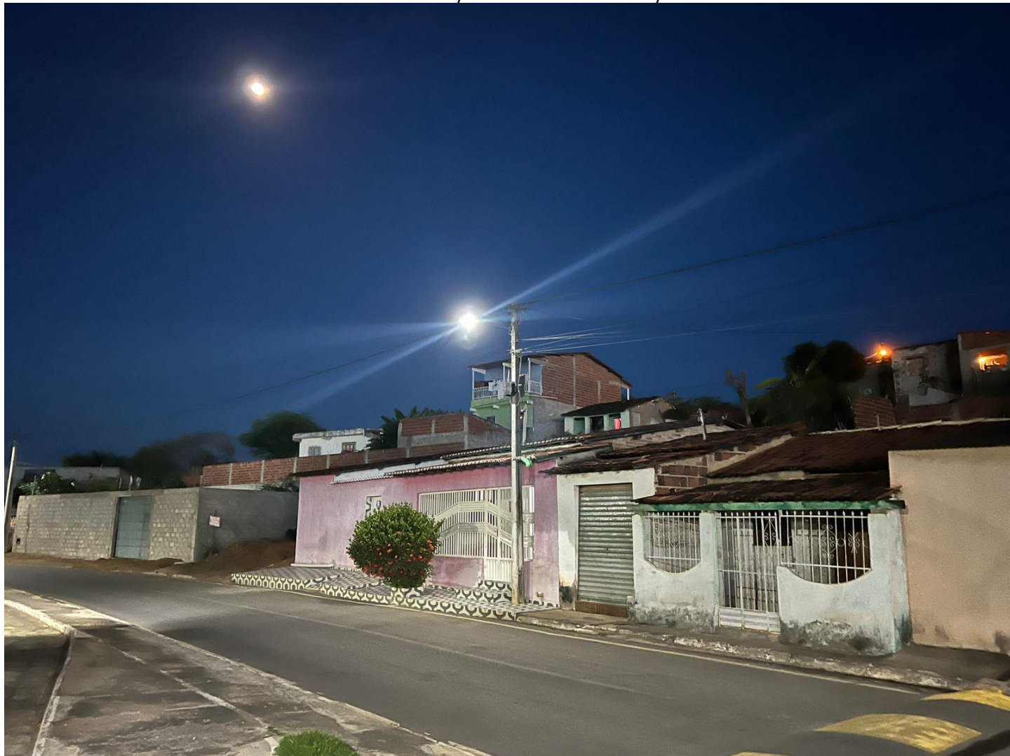
Postes da rua da lagoa
