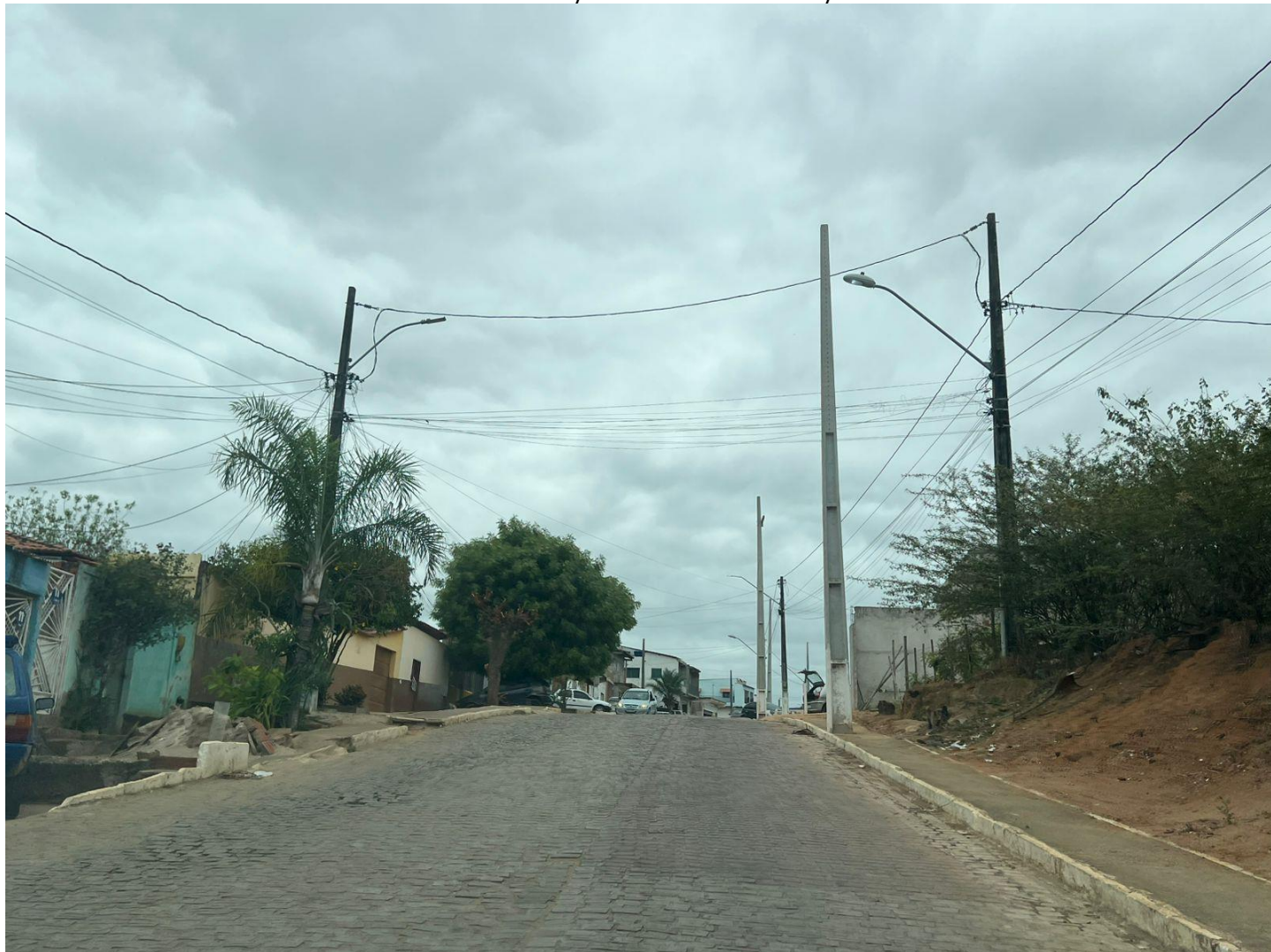
Postes da Rua do Açude
