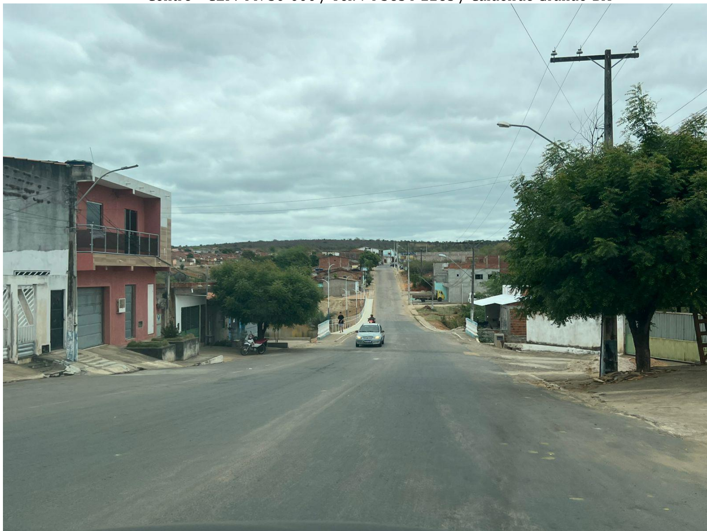
Postes da avenida Hélio Correia
